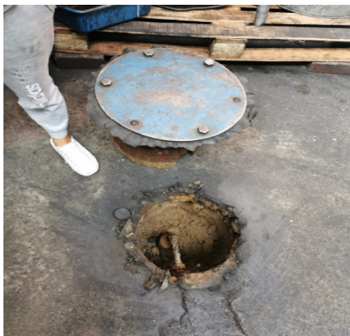
Pozo pz-12-0005 desmantelado.
