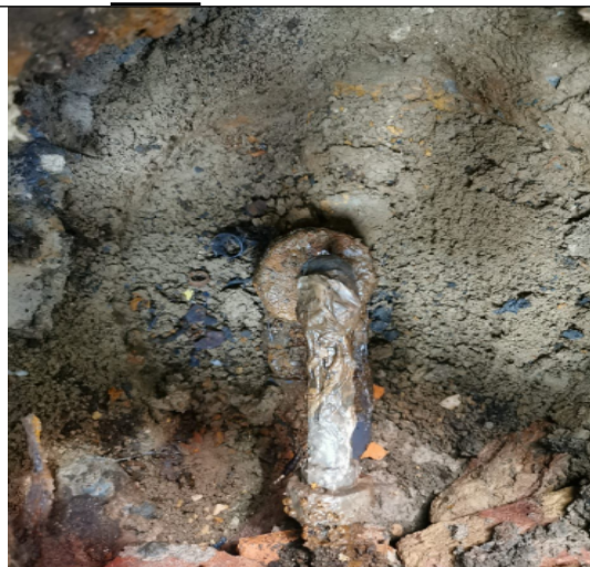
Estado del pozo.
